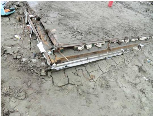
サンプリングの際には、CCA木材が使用されている可能性が高い基部を中心に行うこととした。実際に震災地へ赴き、木材瓦礫のサンプリングを行った。左図では、震災地の倒壊した家屋基礎部分を示している。CCA木材はその特性から主に家屋の基礎部分に使用されている。これらは震災後風雨に晒されており、有毒物質の流出による土壤汚染が懸念される。
